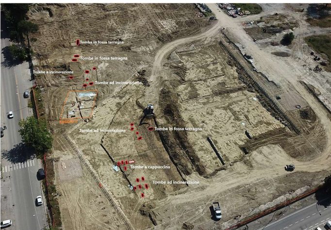
CESENA (FC), QUARTIERE NOVELLO, 2022: AREA IN CORSO DI SCAVO.
